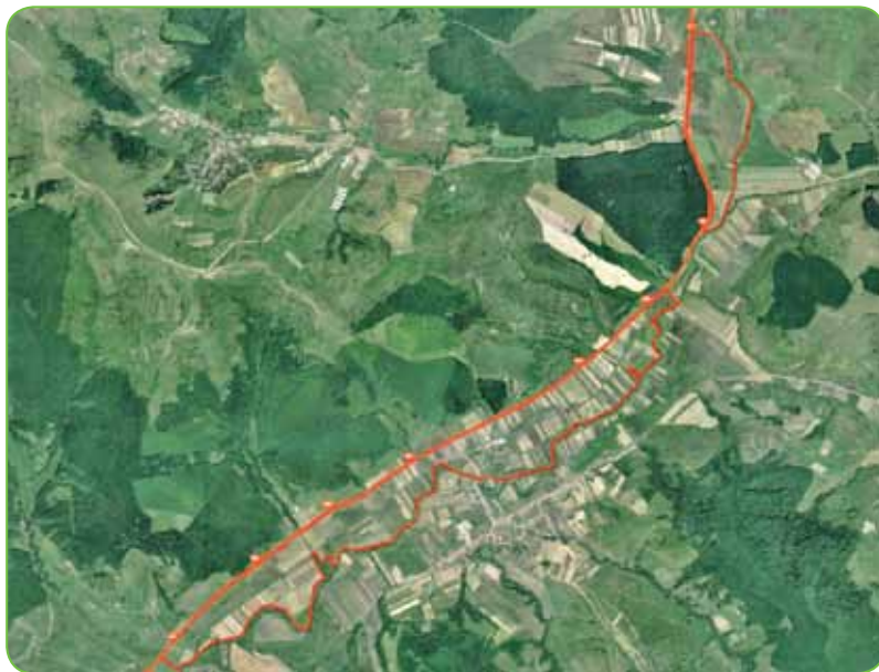
Fig. 5 Tronson de drum pentru care se recomandă limitarea în timp a lucrărilor de rehabilitare
